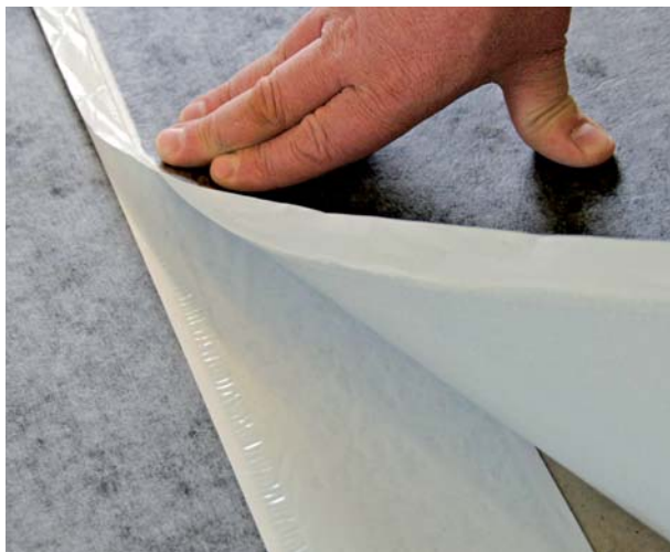
Pozycjonowanie zakładki na styku arkuszy. Krawędzie folii ochronnych muszą się pokrywać.
