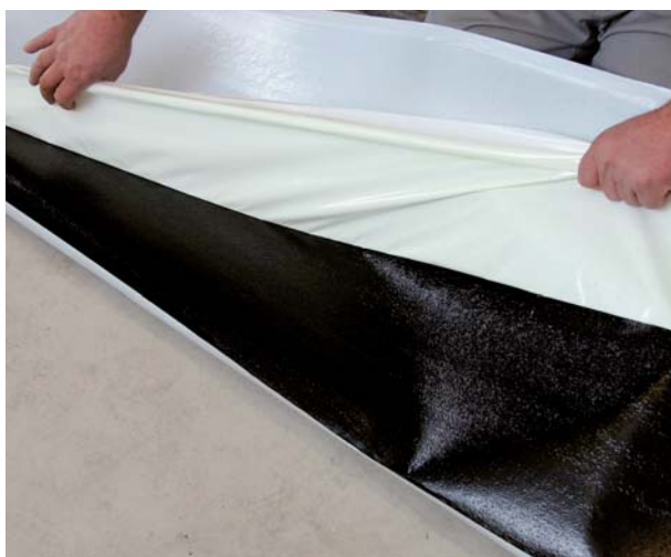
Zdjęcie spodniej folii ochronnej z kolejnego układanego arkusza.
