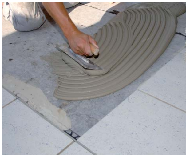
Po uszczelnieniu podłoża PCI Pecilastic WS od razu mogą być układane okładziny ceramiczne.
