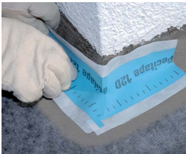
Przyklejenie taśmy uszczelniającej i narożników uszczelniających przy użyciu PCI Seccoral 1K/2K.
