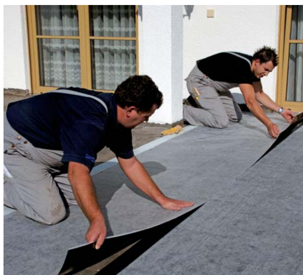
Zastosowanie samoprzylepnych arkuszy uszczelniających PCI Pecilastic WS zapewnia niezawodne uszczelnienie balkonów i tarasów oraz umożliwia natychmiastowe obłożenie płytkami i płytami ceramicznymi.
